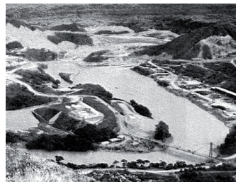
Central Hidroeléctrica de Betania 1986
